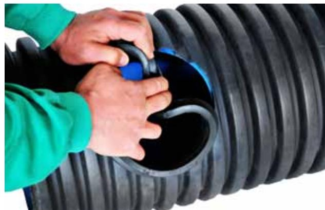
4. Se poziționează conectorul lateral
