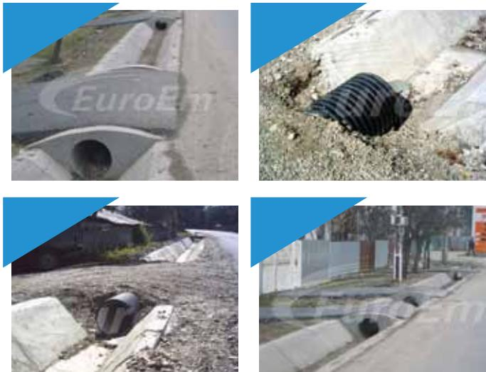
Țevile flexibile oferă avantaje structurale semnificative pentru proiectarea structurilor și sistemelor. Interacțiunea dintre țeava flexibilă și suportul care îl înconjoară este extrem de eficientă în minimizarea caracteristicilor structurale ale tubului, permitând instalarea la adâncimi mari, în general superioare celor acceptabile pentru tuburile rigide montate în condiții similare.
